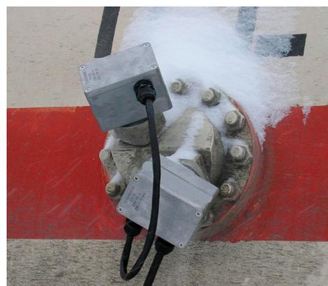
Рис. 7. Монтаж датчика ДЖС-7Б.
